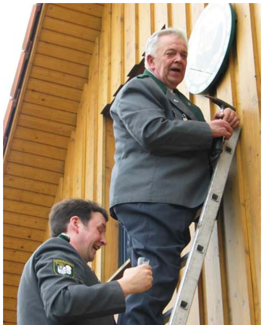
Mit tatkräftiger Unterstützung wird die Scheibe befestigt
